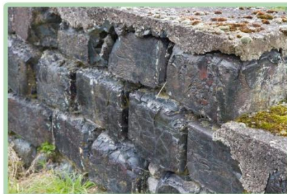
Mur de lingots en scories résiduelles du procédé de fusion utilisé pour extraire le cuivre
