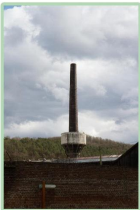
L'usine Tréfinmétaux La cheminée - château d'eau de 82 m
